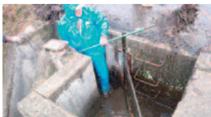
水路の泥上げ
