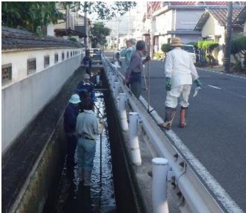
組合員による水路清掃の様子
