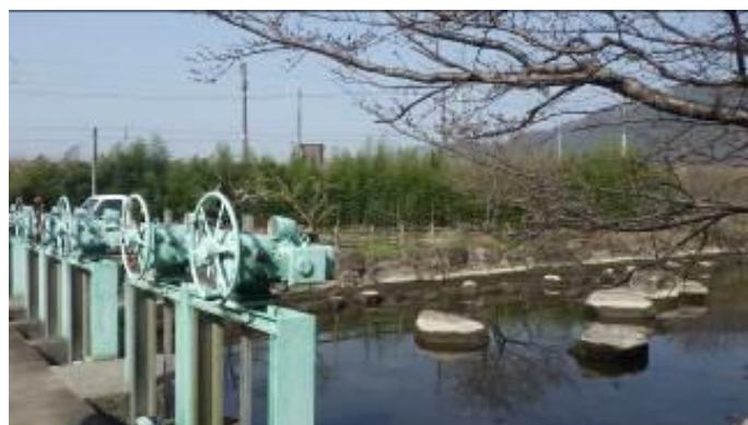
「疏水百選」87 芦田川用水の丸川分水工
