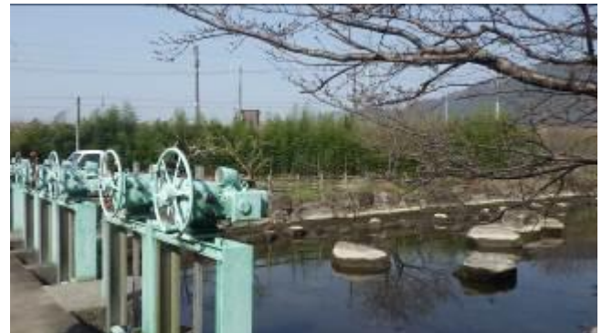
下流へ分水する樋門です
