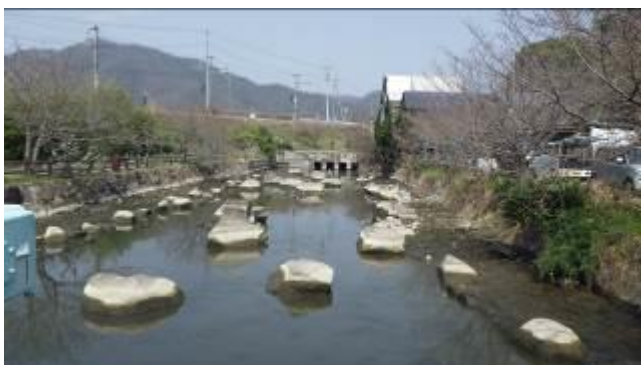
自然石が露わになった丸川分水
