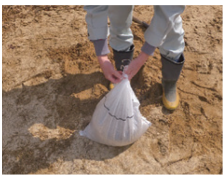
④ 親指を抜いてできたすき間に下から上へひもを通します。緩まないように固く縛りましょう。
