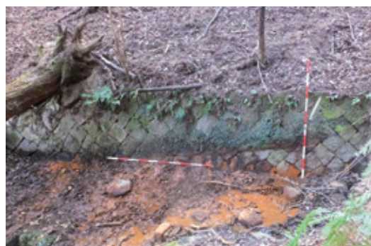
石積からの漏水
