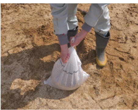
④ 親指を抜いてできたすき間に下から上へひもを通します。緩まないように固く縛りましょう。
