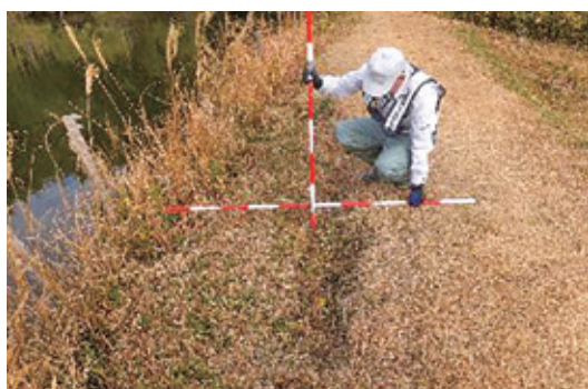
ひび割れ・落ち込み
