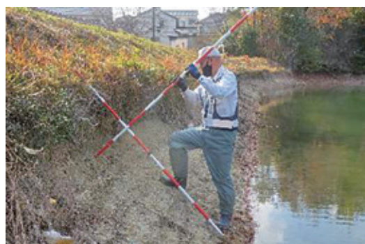
水面側堤の削れ
