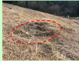
堤体の陥没
