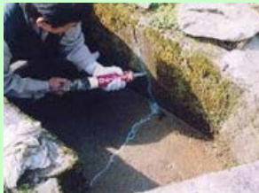
水路のひび割れ補修
