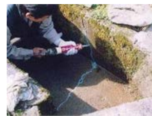
【水路のひび割れ補修】
