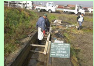
水路の補修・更新
