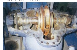
揚水機の分解
