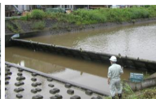
頭首工の診断
