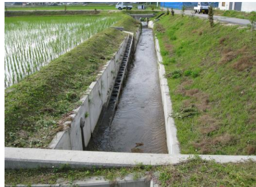
農業農村整備事業は、環境との調和への配慮が必要です。 ほ場整備で水田魚道を設置し生物に配慮した排水路を整備 経営体育成基盤整備事業 川尻地区（世羅町）
