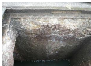
コンクリートの腐食
