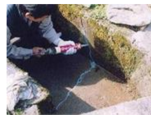
【水路のひび割れ補修】
