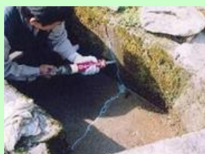
水路のひび割れ補修
