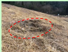
堤体の陥没
