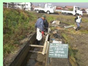
水路の補修・更新
