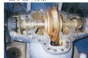
揚水機の分解
