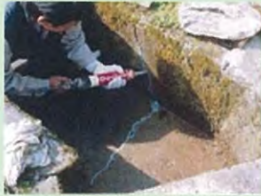
水路のひび割れ補修
