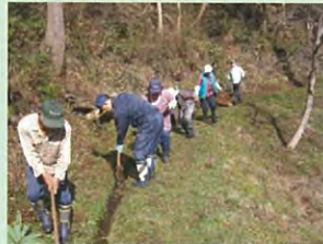
水路の泥上げ
