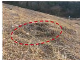
堤体の陥没
