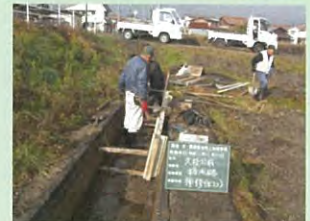
水路の補修・更新
