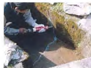
【水路のひび割れ補修】
