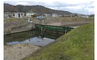
頭首工の診断
