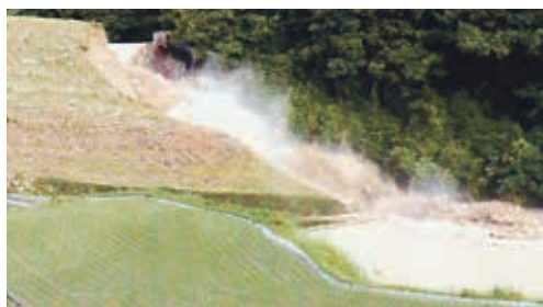
平成28年6月23日に発生したため池の決壊状況（福山市）
