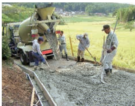
農道のコンクリートによる舗装
