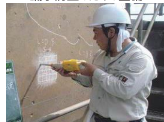
老朽化した施設の機能診断
