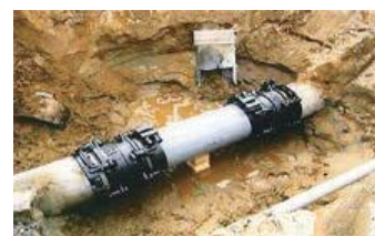
漏水防止のための整備
