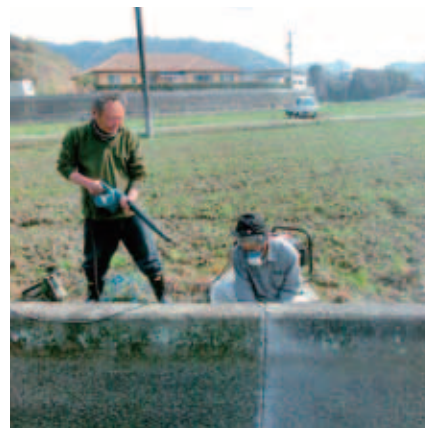
コンクリート継ぎ目補修
