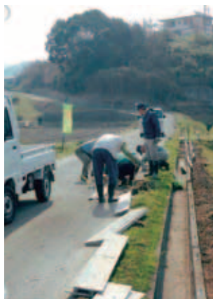
用水路嵩上げ作業
