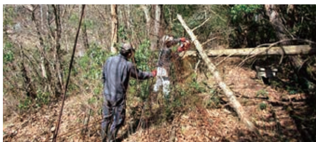
防護柵の補修・設置
