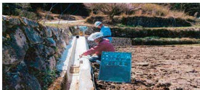
長寿命化 水路の更新
