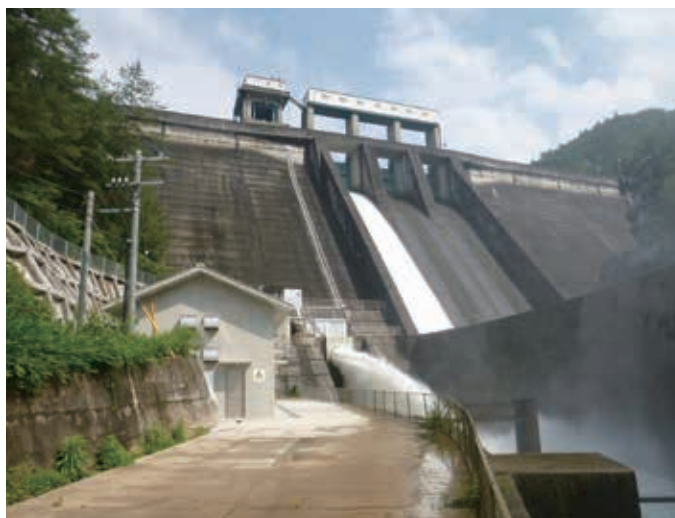
ダム全景と発電施設建屋（写真左下）
