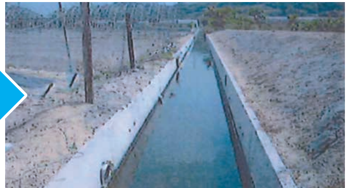
三面コンクリート水路
