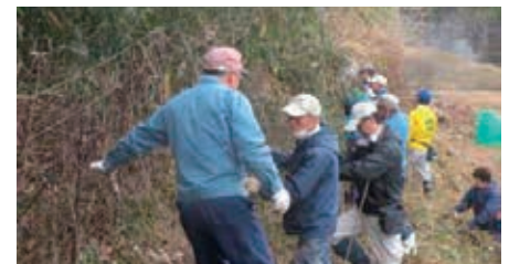
防護柵周辺の雑木伐採
