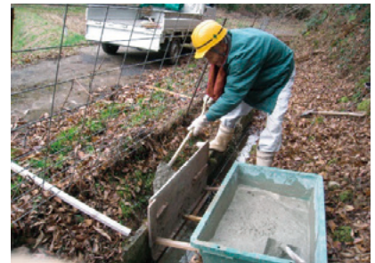
構成員による直営施工
