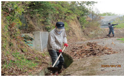
水路の泥上げ作業
