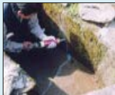
ひび割れの補修
