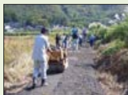
未舗装農道の舗装
