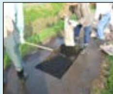
農道の部分補修
